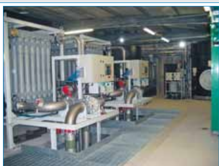
Stacje uzdatniania wody z wykorzystaniem układu mikrofiltracji ciśnieniowej.
