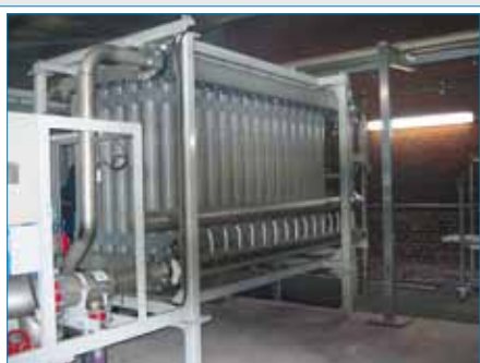
Kompaktowy układ ciśnieniowy SUW montowany w ramie.
